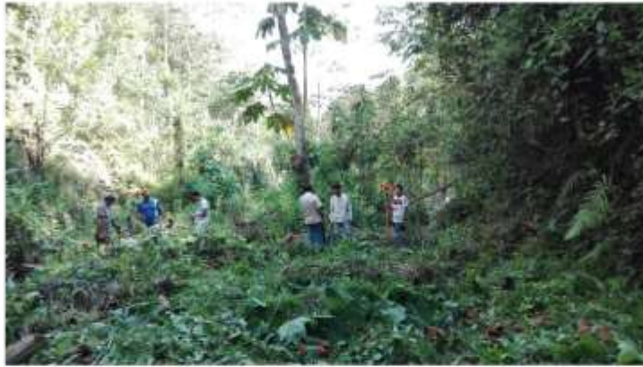
REALIZANDO LOS TRABAJOS TOPOGRÁFICOS
