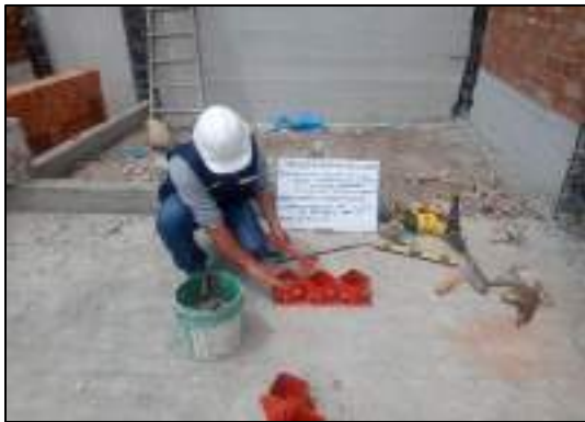
Elaboración de cubos de mortero
