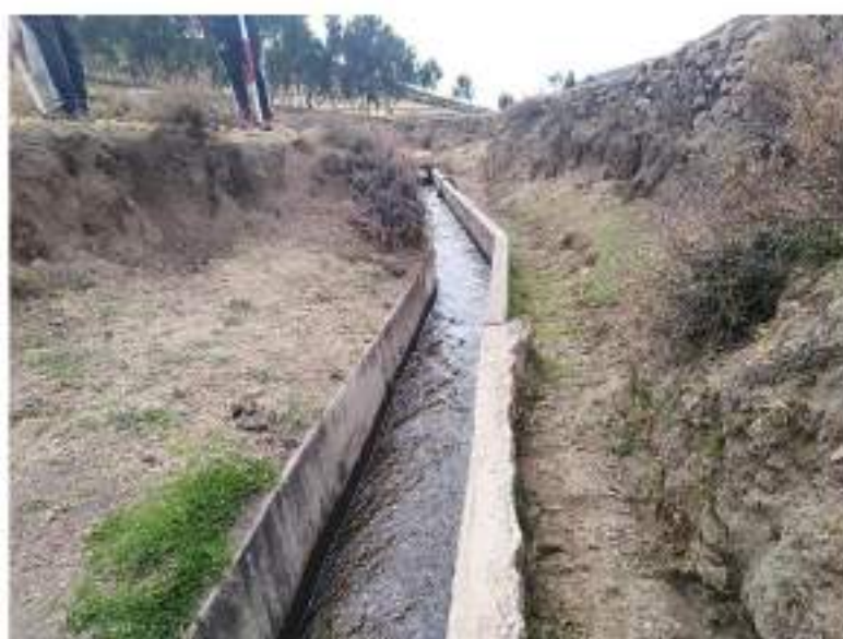
CANAL DE RIEGO EXISTENTE EN EL AREA DEL VVERO DE PROYECTO – SECTOR SANTO DOMINGO DE CAPILLAS
